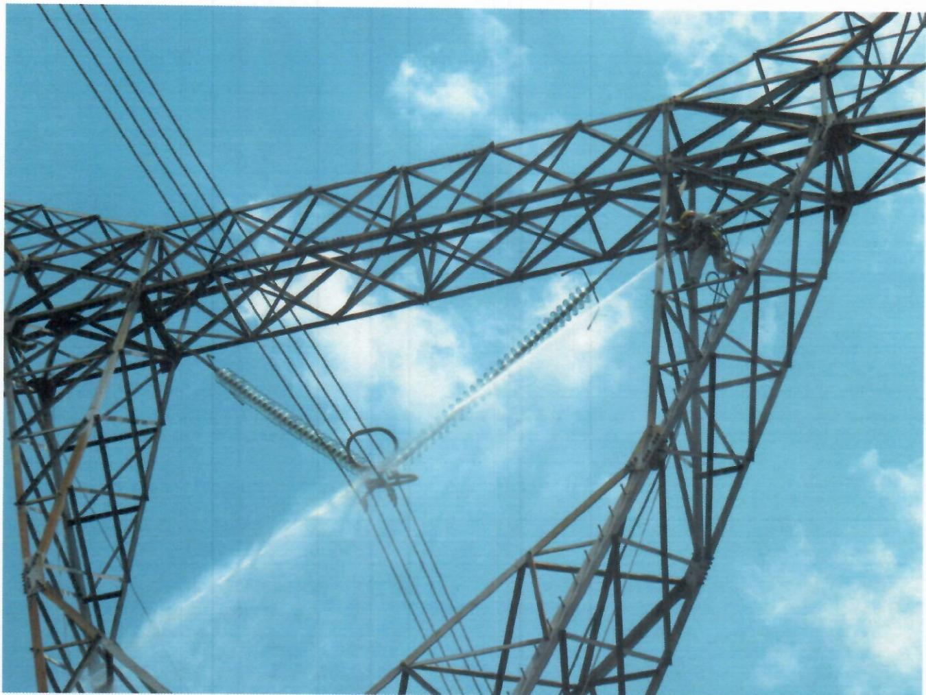
Hệ thống lưới điện truyền tải khu vực Truyền tải điện Đăk Nông chịu ảnh hưởng bởi điều kiện thời tiết khắc nghiệt, vào mùa khô ngày nắng nóng kéo dài, đêm sương mù dày đặc, nhiệt độ môi trường dao động với biên độ rất lớn (nhiệt độ ban ngày trên  $35^{\circ}\text{C}$ , ban đêm xuống dưới  $15^{\circ}\text{C}$ ), bụi đất đỏ bazan, bụi từ các công trình xây dựng, khai thác nông-lâm-khoáng sản... Các yếu tố trên làm cho cách điện nhanh chóng bị bám bụi, suy giảm cách điện theo thời gian vận hành.
